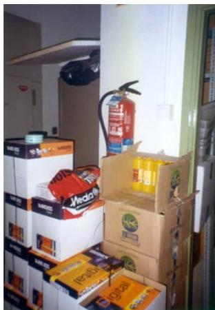
Foto N° 3 Extintor bloqueado dificulta su utilización en el caso de un incendio (Fuente: www.spl.upv.es)
